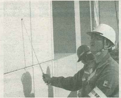
マンションの劣化診断の様子。何十項目にも及ぶ状態・性能についてチェックします
