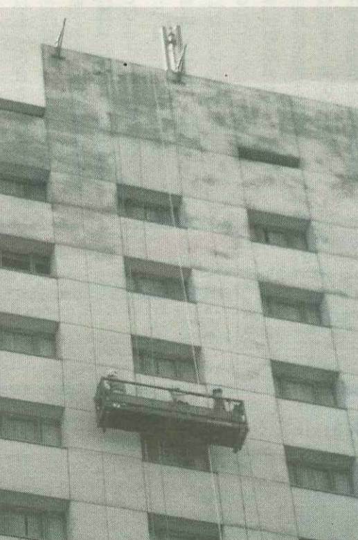
屋上からゴンドラを架設して外壁を診断。打診してタイルの浮きなどを調査します
