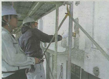
外壁の改修工事。工事の設計を手掛けた建築士(左)が、きちんと施工されているか監理する
